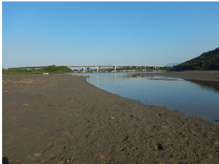
(d) Survey Location at THW
